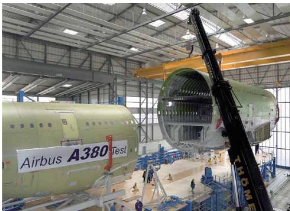
Fábrica de Airbus calefactada por paneles de Techo Radiante (ver bandas blancas en el techo)
