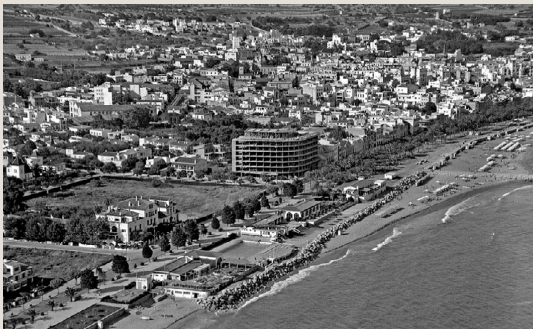
Figura 9. Fotografia del que als anys seixanta encara quedava del mur d'escullera de protecció del passeig (Alegre, 2015).
